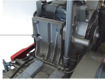
รูปที่ 13.33 การประกอบแท่นยึดฐานรองถังน้ำมันเชื้อเพลิง
