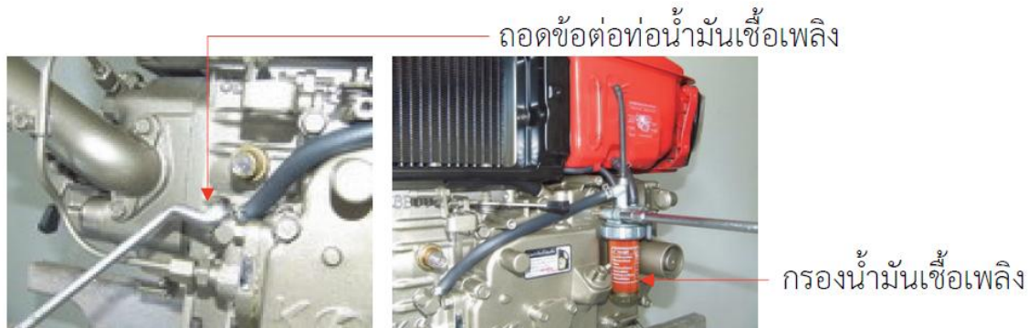
รูปที่ 10.4 การถอดกรองน้ำมันเชื้อเพลิง
