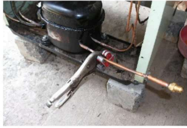
ใช้คีมบีบท่อบีบไม่ให้รั่วแล้วตัดออก
