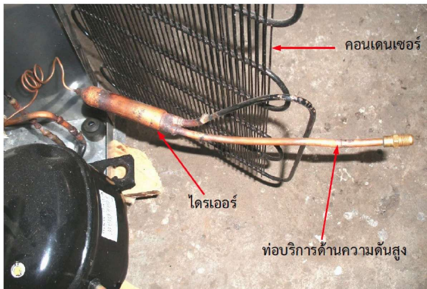
การติดตั้งท่อบริการด้านความดันสูงแบบเชื่อมเข้าไดรเออร์
