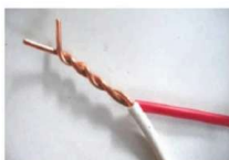
บิดด้วยมือ 4-5 รอบ ใช้คีมบิดให้แน่น
