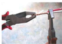
บิดด้วยมือ 4-5 รอบ ใช้คีมบิดให้แน่น
