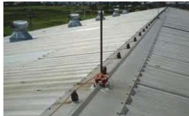
ตำแหน่งตัวนำล่อฟ้าบนพื้นผิวของหลังคา
