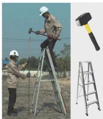
ก) การตอกหลักดินโดยใช้ค้อนปอนด์
