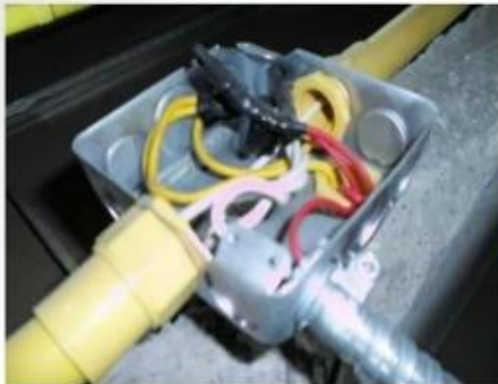
การต่อสายไฟโดยใช้เทปพันสาย
