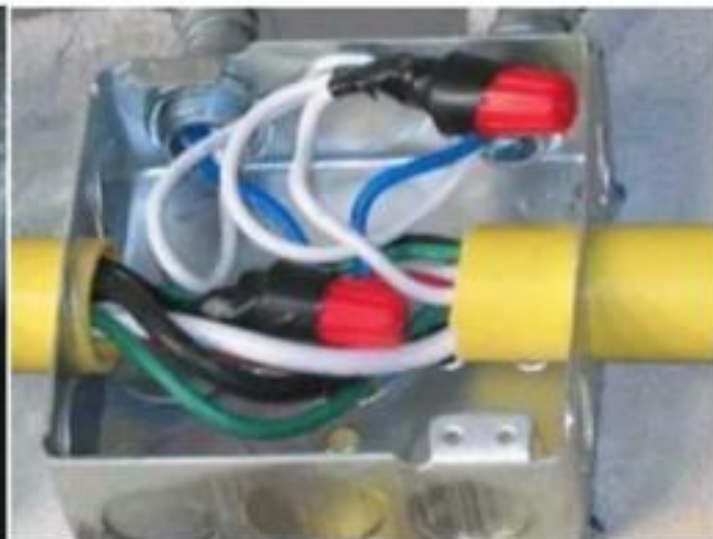
การต่อสายไฟฟ้าโดยใช้ไวร์นัท (Wire nut)
