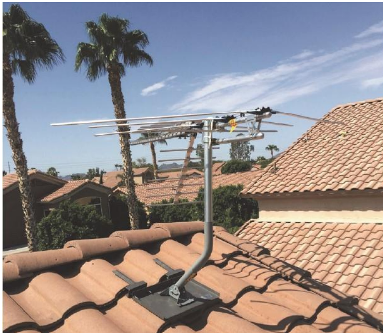
การติดตั้งเสาอากาศบนหลังคาบ้าน
