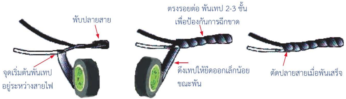
ข) การใช้เทปพันสายไฟพันรอยต่อสายไฟฟ้า รูปที่ 1.4.11 การหุ้มฉนวนรอยต่อสายไฟฟ้า
