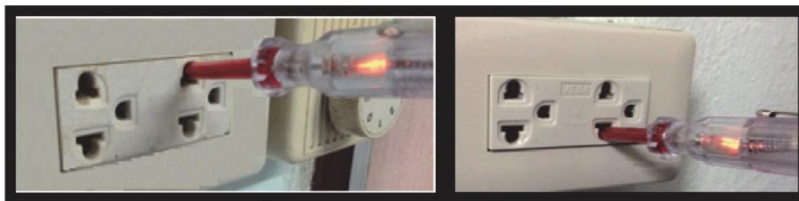
✓ วัดขั้วบนหลอดสว่าง อีก 2 ขั้ว หลอดไม่สว่างแสดงว่าติดตั้งถูกต้อง
