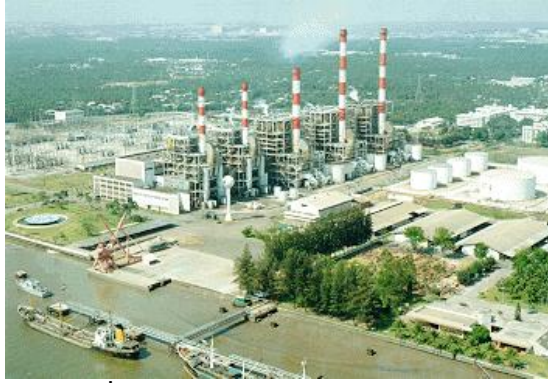
รูปที่ 1.3.4 โรงไฟฟ้าพลังความร้อนร่วม
