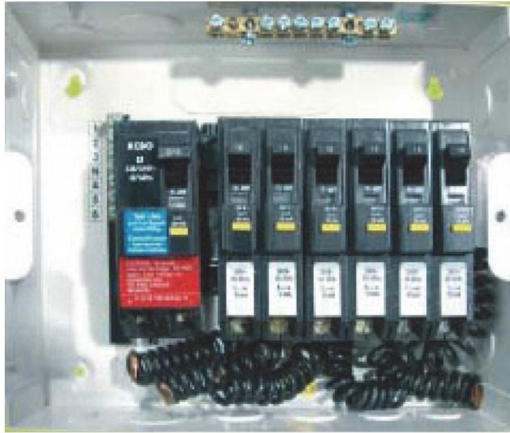
รูปที่ 4.1.5 ตัวอย่างเซอร์กิตเบรกเกอร์ป้องกันกระแสรั่วและการนำไปใช้ติดตั้ง
