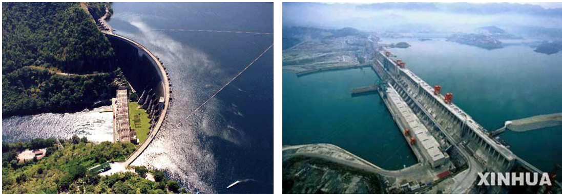
รูปที่ 1.3.2 โรงไฟฟ้าพลังน้ำ
