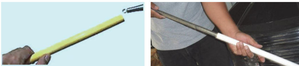
รูปที่ 3.1.8 การใส่สปริงตัดท่อให้พอดีกับท่อ
