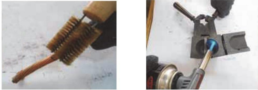
ก) ทำความสะอาดโมลด์ สายต่อหลักดินและหลักดิน ข) ไล่ความชื้นโมลด์ สายต่อหลักดินและหลักดิน
