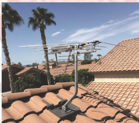
รูปที่ 5.1.1 การติดตั้งเสาอากาศบนหลังคาบ้าน
