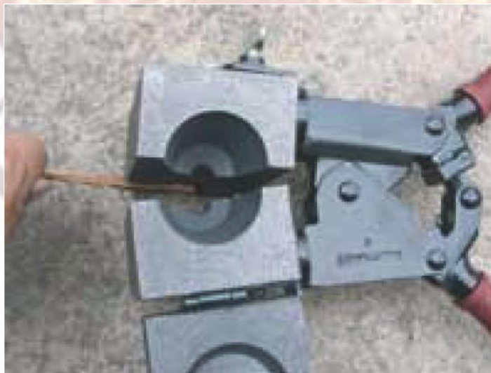
รูปที่ 4.1.30 ติดตั้งโม่ลด์เข้ากับสายต่อหลักดินและหลักดิน
