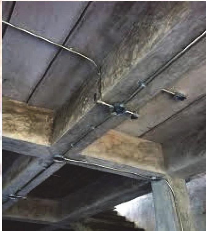
รูปที่ 3.1.6 ตัวอย่างการติดตั้งระบบท่อโลหะบางก่อนเดินสายร้อยท่อ
