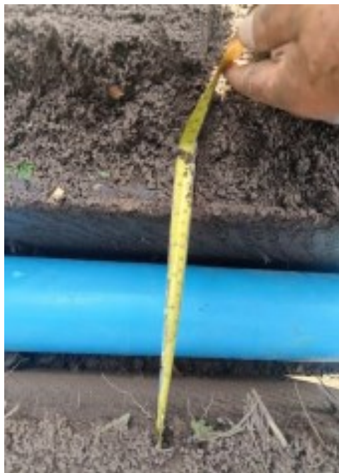
ภาพที่ 4.5 ความกว้างร่องที่ได้จากเครื่องขุดดินฝังท่อ
