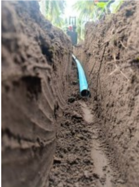
ภาพที่ 4.4 ความลึกร่องที่ได้จากเครื่องขุดดินฝังท่อ
