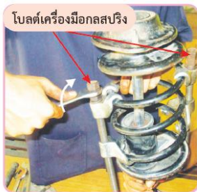
รูปที่ 8.11 ขันโบลต์เครื่องมือถอดสปริง
