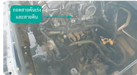
รูปภาพที่ 4.8 ถอดสายคันเร่งและสายดิน
