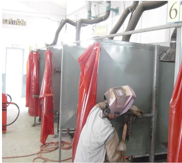
รูปที่ 5.9 แสดงระบบการระบายอากาศในห้องเชื่อม
