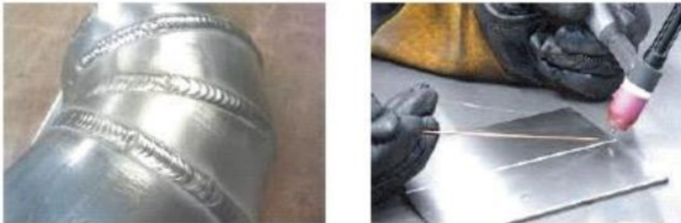
รูปที่ 3.17 ลักษณะงานเชื่อมอะลูมิเนียมด้วยการเชื่อมอาร์กทั้งสแตนเลสคลุม
