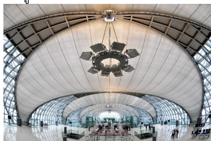
โรงหลังคาทำอากาศยานสุวรรณภูมิ เป็นโครงสร้างที่ใช้การเชื่อมประกอบชิ้นรูป
