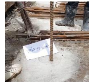
ค) เสียบเหล็กต่อคาน
