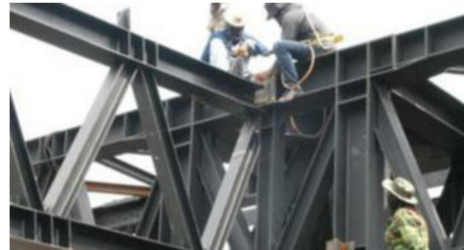
แสดงลักษณะงานเชื่อมเหล็กกล้าคาร์บอนต่ำ
