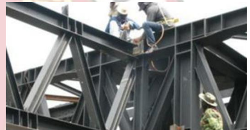
แสดงลักษณะงานเชื่อมเหล็กกล้าคาร์บอนต่ำ
