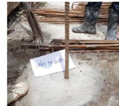
ค) เสียบเหล็กต่อคาน
