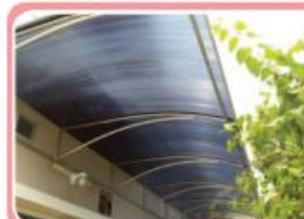
ภาพที่ 8.6 กันสาด ทำมาจากโพลีคาร์บอเนต
