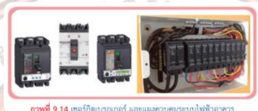
ภาพที่ 9.14 เซอร์กิตเบรกเกอร์ และแผงควบคุมระบบไฟฟ้าอาคาร
