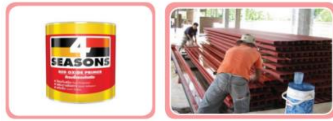
ภาพที่ 8.11 สีรองพื้นแดงกันสนิม และการใช้งานทาเหล็ก
