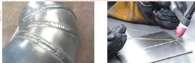
รูปที่ ๔.๑๗ ลักษณะงานเชื่อมอะลูมิเนียมด้วยการเชื่อมอาร์กทั้งสแตนแก๊สคลุม
