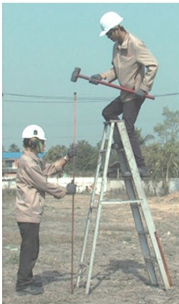
ก) การตอกหลักดินโดยใช้ค้อนปอนด์
