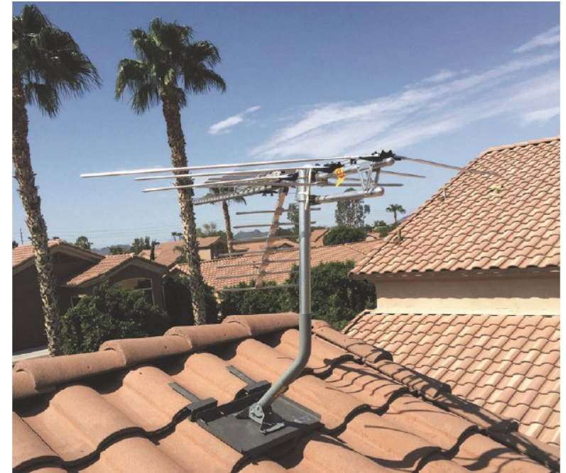
การติดตั้งเสาอากาศบนหลังคาบ้าน
