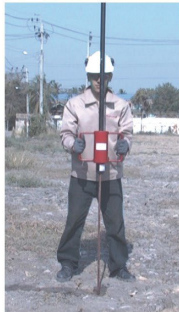
ข) การตอกหลักดินโดยใช้เครื่องมือตอกหลักดิน
