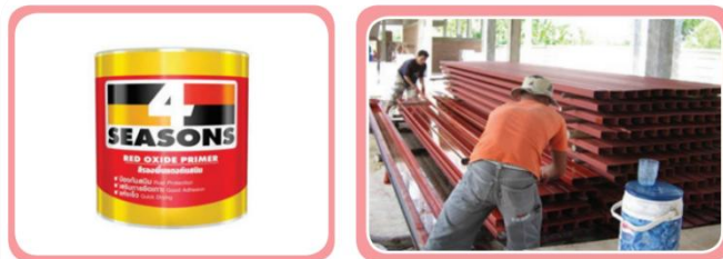
ภาพที่ 8.11 สีรองพื้นแดงกันสนิม และการใช้งานทาเหล็ก
