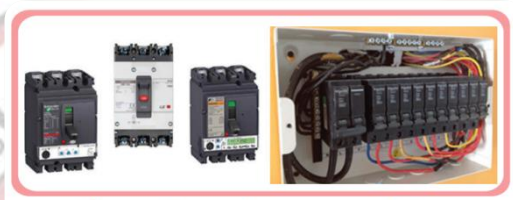
ภาพที่ 9.14 เซอร์กิตเบรกเกอร์ และแผงควบคุมระบบไฟฟ้าอาคาร
