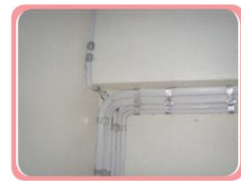
ภาพที่ 9.20 ลักษณะของเช็มขัดรัดสายไฟฟ้า และการใช้งานพันสายไฟฟ้า
