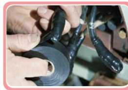
ภาพที่ 9.19 ลักษณะของเทปพันสายไฟฟ้า และการใช้งานพันสายไฟฟ้า
