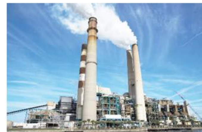
โรงไฟฟ้า
