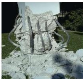
รูปที่ 1 (ซ้าย) การแตกหักของเพลาคอเหวี่ยง และ (ขวา) การแตกหักของเสารับน้ำหนัก
