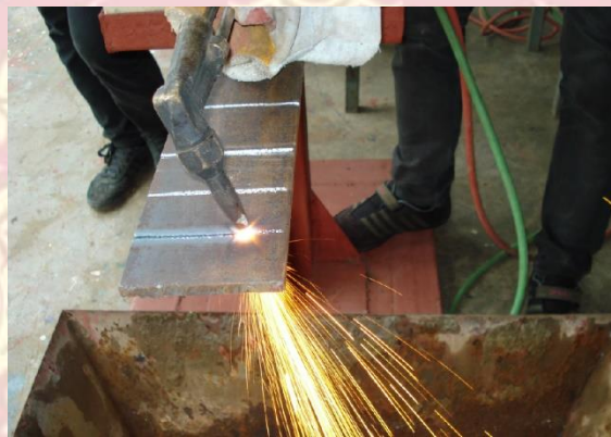
รูปที่ ๔.๑๐ การตัดตรงด้วยมือ
