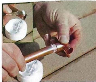
ภาพที่ 5.7 การทาฟลักซ์ชนิดครีมในการเล่นประสาน ที่มา: http://www.plumbing.about.com/od/basics/ss/How-To-Solder-Copper-Pipe
